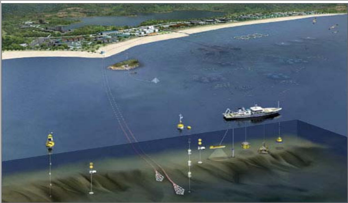
▲ 2006년 말 완공될 동해 심층수 개발센터 조감도. 두 개의 시추관이 300m와 500m 수심에서 매일 1100톤의 심층수를 끌어올린다.
