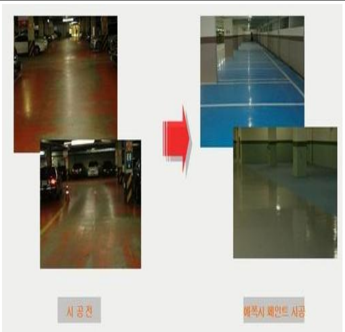
그림1. 에폭시 수지 바닥코팅 전, 후
